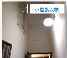
廊下 勾配天井
